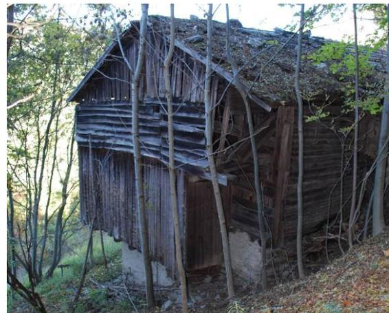
(2) Nelle operazioni di recupero si raccomanda, ove possibile, il risanamento del tavolato in legno e la sostituzione degli elementi deteriorati, piuttosto che la sostituzione completa di tutti gli elementi. E' ammessa la realizzazione di nuovi fori, nel caso di
